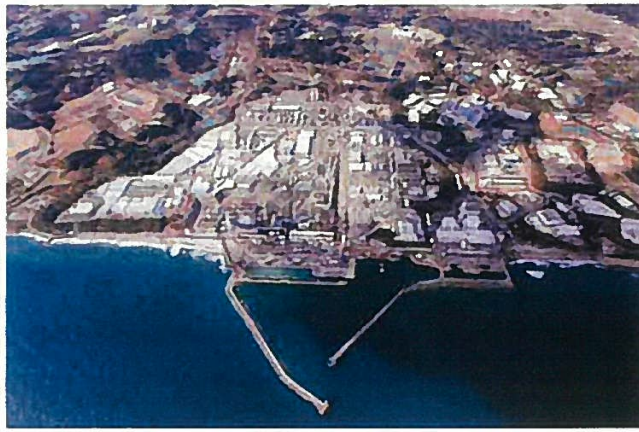
処理水の海洋放出が続く東京電力福島第1原発=1月12日、福島県大熊町で、本社ヘリ「おおづる」から
