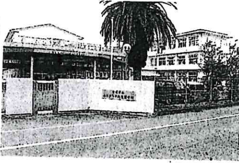
敷地内に高等特別支援学校の新設が計画されている、みやぎ中央支援学校II宮崎市島之内
