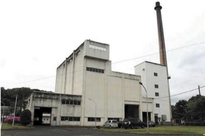
現在地に新施設を整備する方針の清掃工場＝塩釜市杉の入
