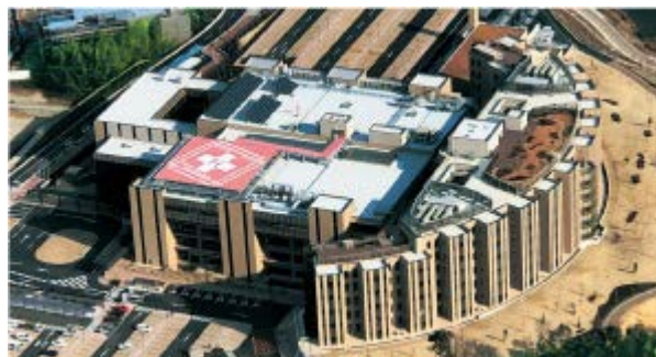
新奈良県総合医療センター
